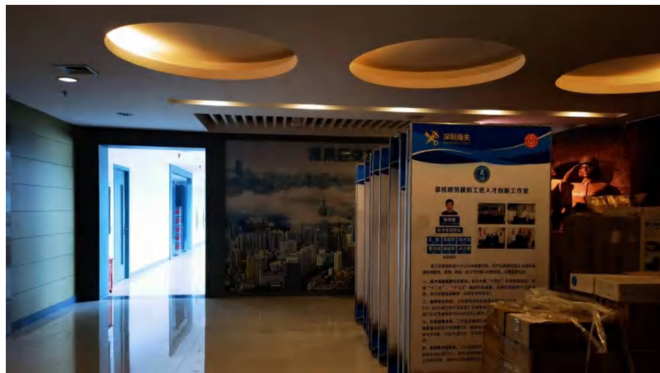
如图所示展厅内部有大量墙体需新砌 天花需改造
