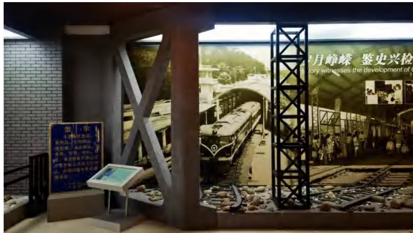
展厅内部有大量旧墙面装饰需拆除
